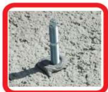
ANCORAGGIO DI UNA BARRA FILETTATA SU CEMENTO
