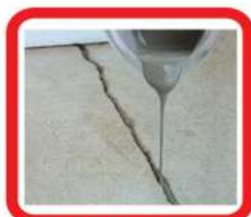
SIGILLATURA DI FESSURE SU PAVIMENTI IN CEMENTO
